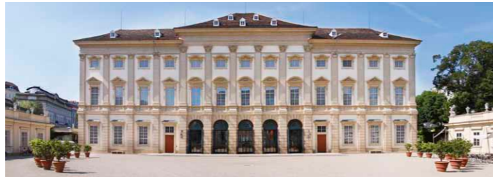
Die Südfassade des Gartenpalais Liechtenstein
